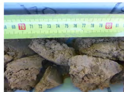
S07 : Détail du sondage
